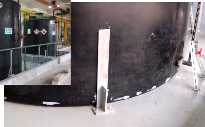
次氯酸鈉槽之錨定
